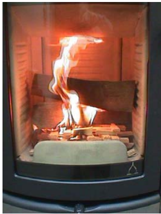
Fig. 5: Primärluftschieber schließen
